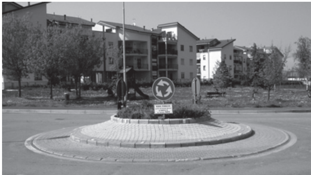
La prima rotatoria di Manta, realizzata in via Matteotti
