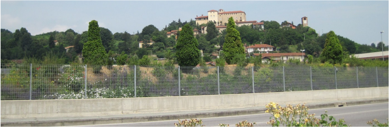
Duna di protezione acustica della scuola primaria
